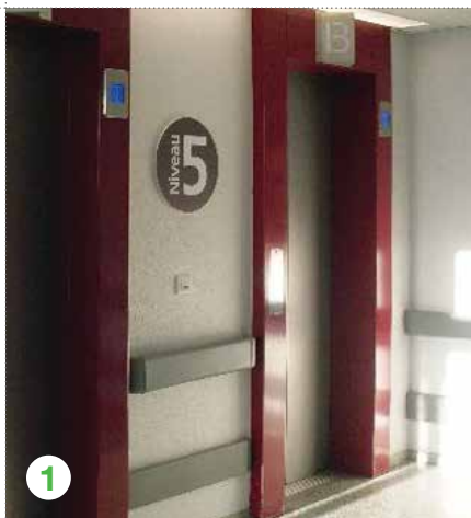
1 et 2 - Les usagers rentrent leur étage de destination en utilisant des écrans tactiles, et reçoivent instantanément la désignation de la cabine qui leur est affectée.
